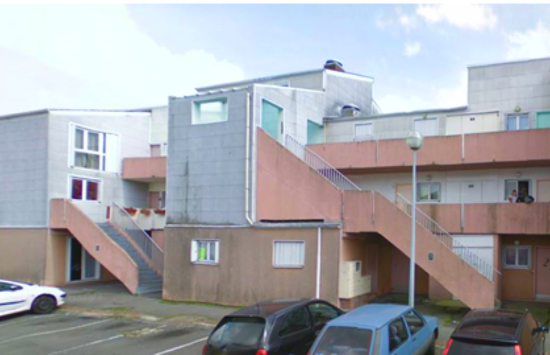
Site avant la réhabilitation
