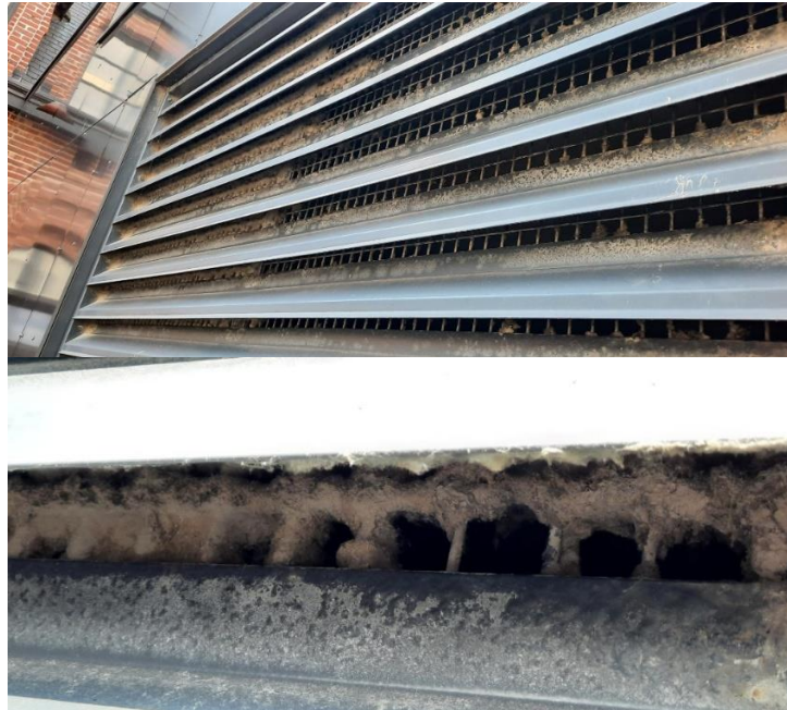
Figure 5: Grille d'aspiration de l'air neuf d'une CTA
