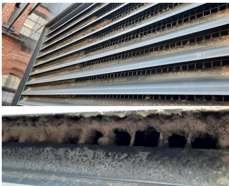
Figure 5: Grille d'aspiration de l'air neuf d'une CTA
